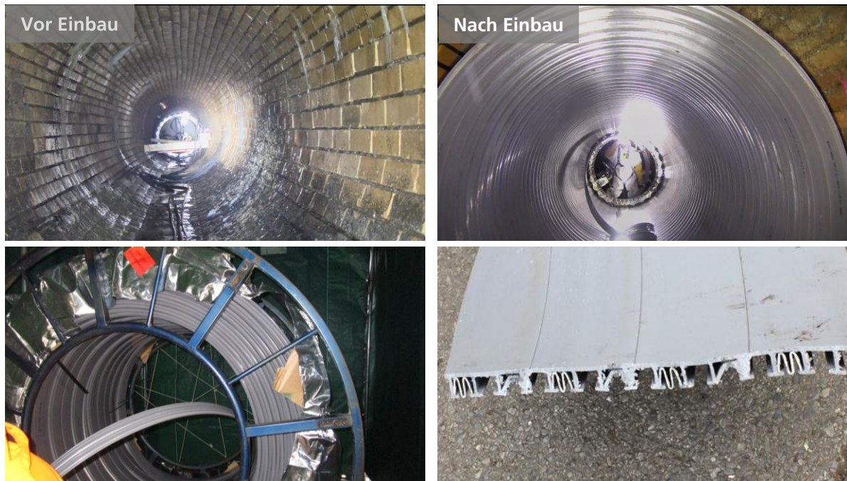
Abbildung 4 – Maßnahme Florastraße - Einbau im Wickelrohrverfahren
