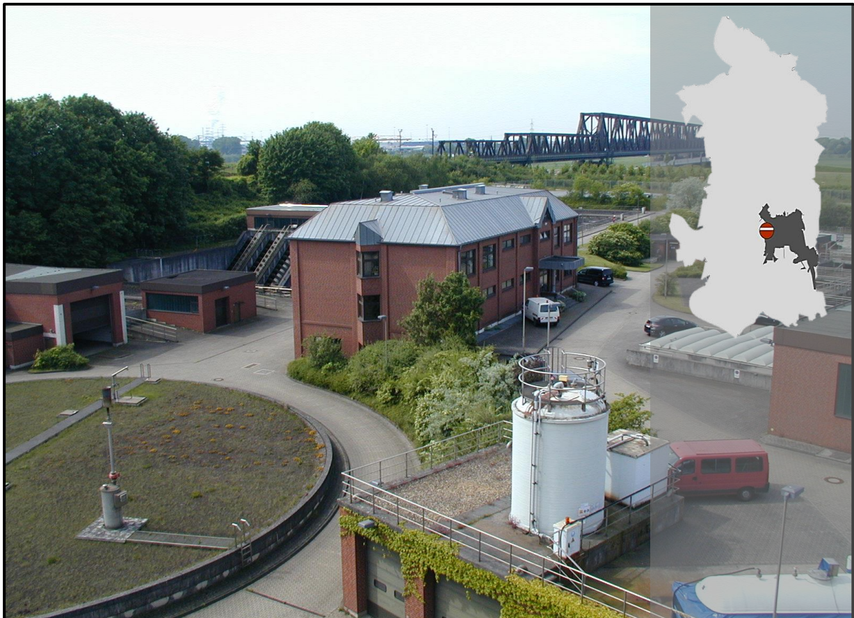
Abbildung 10 - Kläranlage Hochfeld mit Einzugsgebiet
