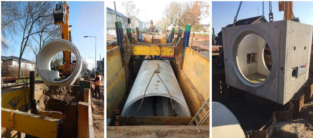
Abbildung 3 - Maßnahme Regenrückhaltekanal Herzogstraße
