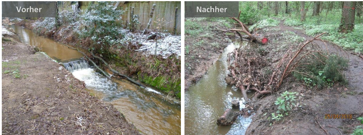
Abbildung 25 - Maßnahme am Haubach - Entfernung Durchgängigkeitshindernis (AS_31)
