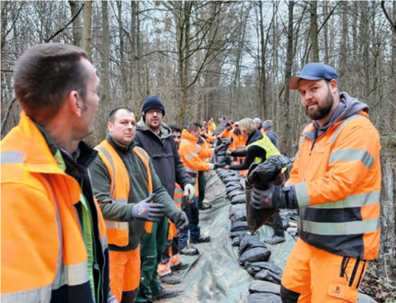
Damm aus 8.500 Sandsäcken
